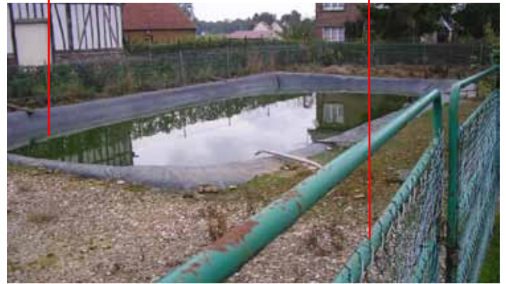
Clôture non intégrée dans le paysage
