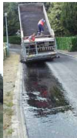
Application d'enduit superficiel gravillonné
