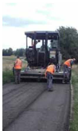
Reprofilage de chaussée en graves émulsion
